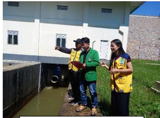
Saluran Pembuang Rumah Katup
