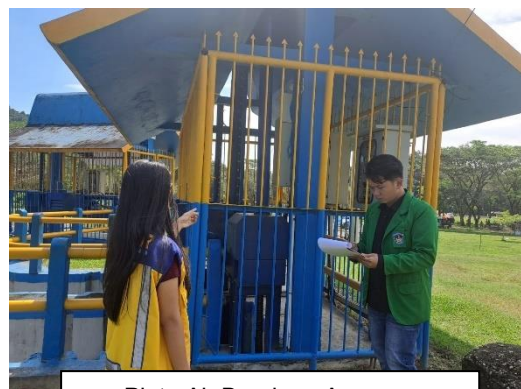
Pintu Air Bendung Ameroro
