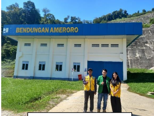
Bangunan Rumah Katup
