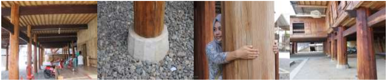
Gambar 5. Tiang Rumah Tolotang yang berbeda rumah bugis sumber : Hasil Pengamatan lapangan Penulis 2016.
