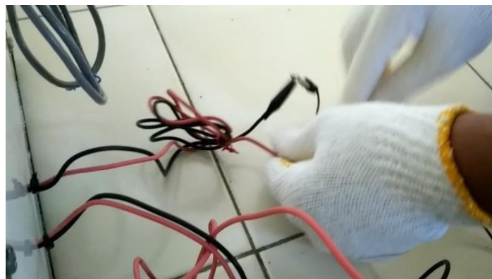
Gambar 6. Pemasangan jack pada lampu
