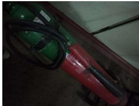
Gambar 5.19 Kondisi aktual sistem pemadam luapan pada bangunan gedung Pasar Sentral ( New Makassar Mall )
