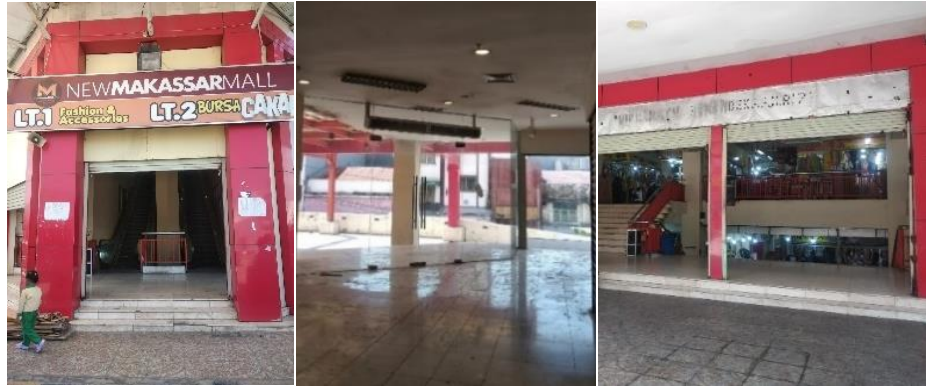
Gambar 5.10 Kondisi jalan masuk utama atau keluar pada bangunan gedung Pasar Sentral ( New Makassar Mall )
