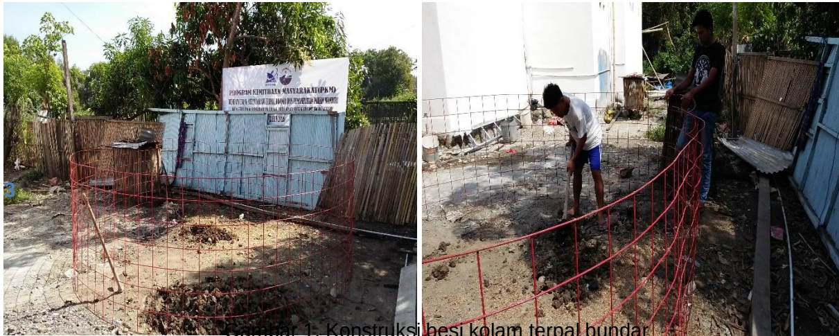
Gambar 1. Konstruksi besi kolam terpal bundar
