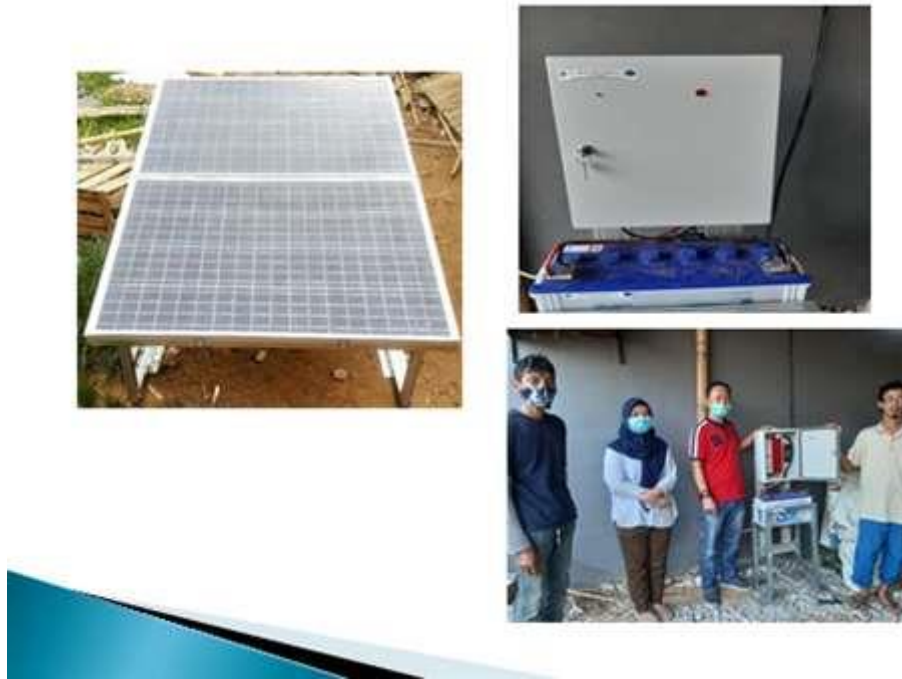
Gambar 2. Hasil penerapan PLTS untuk mesin penetas telur
