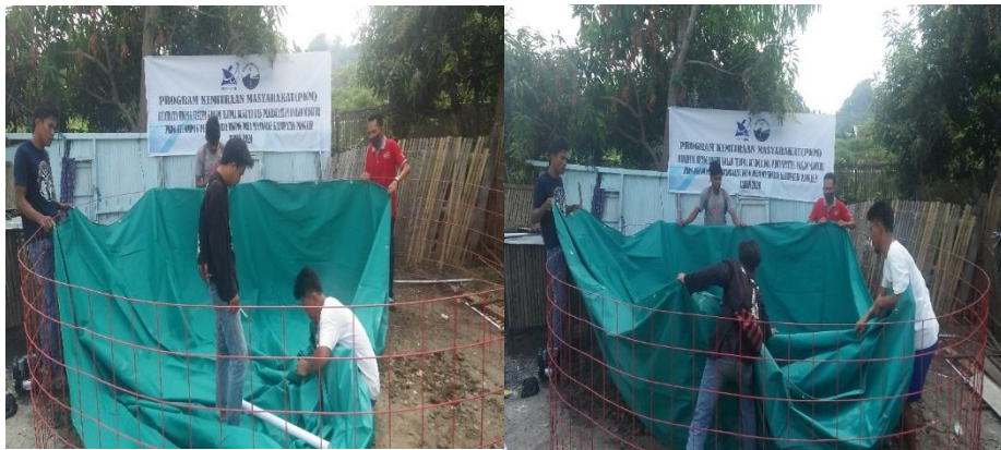
Gambar 2. Pembuatan saluran pembuangan dan pemasangan terpal
