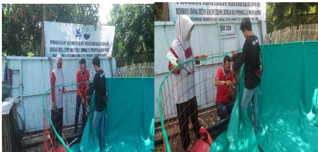
Gambar 5. Pemasangan kolam terpal bundar
