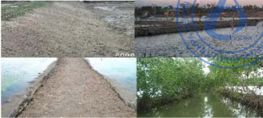
Gambar 3.1. Kondisi Pematang dalam penguatan kostruksi pematang baik dengan melapisi dinding pematang dengan semen maupun dengan melakukan penanaman mangrove disekitar pematang tambak
