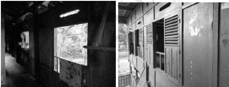
Gambar 4.49 Jendela (Sumber: Dokumen Pribadi)
