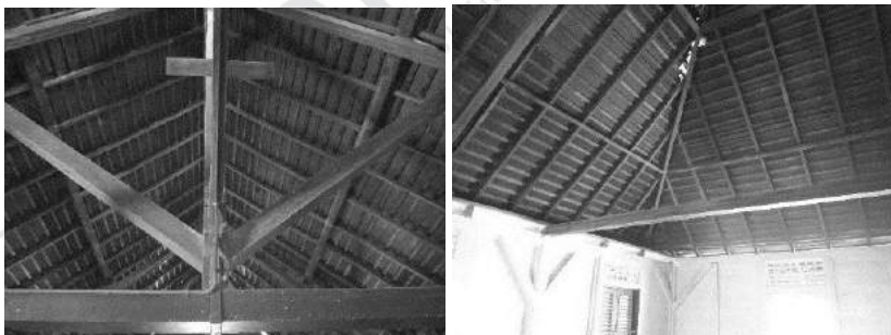
Gambar 4.41 Konstruksi atap rumah Saoraja (Sumber: Dokumen Pribadi)
