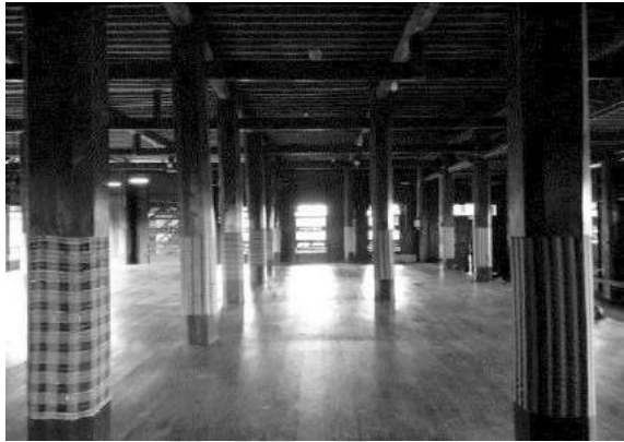
Gambar 4.12 Tempat duduk bangsawan (Sumber: Dokumen Pribadi)
