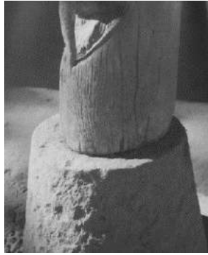
Gambar 4.53 Fondasi titik rumah tiang bulat (Sumber: Dokumen Pribadi)
