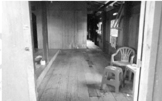
Gambar 4.47 Perbedaan elevasi lantai (Sumber: Dokumen Pribadi)
