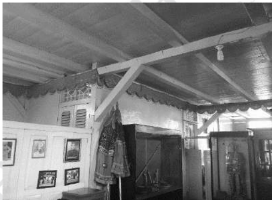
Gambar 4.39 Kamar (Sumber: Dokumen Pribadi)
