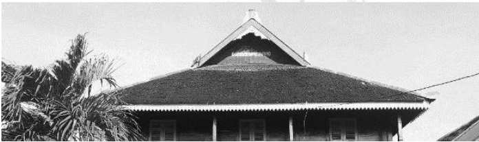
Gambar 4.87 Atap rumah Saoraja Mallangga (Sumber: Dokumen Pribadi)
