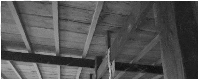
Gambar 4.85 Plafon rumah menteri (Sumber: Dokumen Pribadi)
