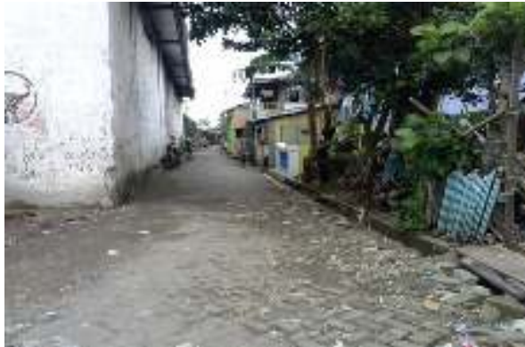
Gambar 38 : Kondisi Jalan Sumber : Survey Maret 2015
