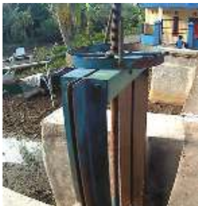
Gambar 18. Pintu air di desa Untia Sumber : data survey
