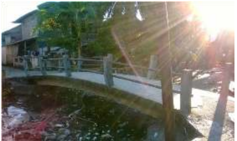
Gambar 16. Jembatan desa untia kecamatan bringkanaya Sumber : data survey
